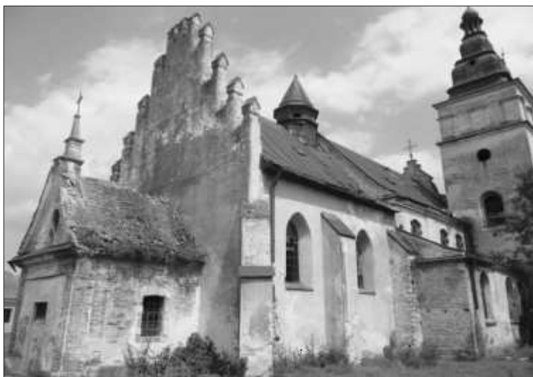
Kościół parafialny w Wyżnianach z 1444 r., najstarsza budowla sakralna na terenie byłego powiatu przemysłańskiego, Obecnie niszczący.
