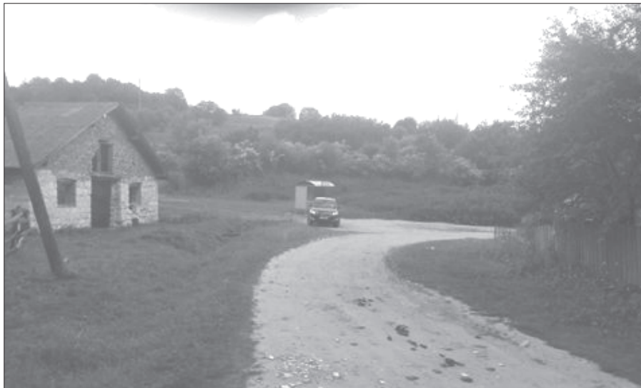
Rozpoczęta budowa domu w Plenikowie przy przystanku. Fot Janusz Rozwadowski.
