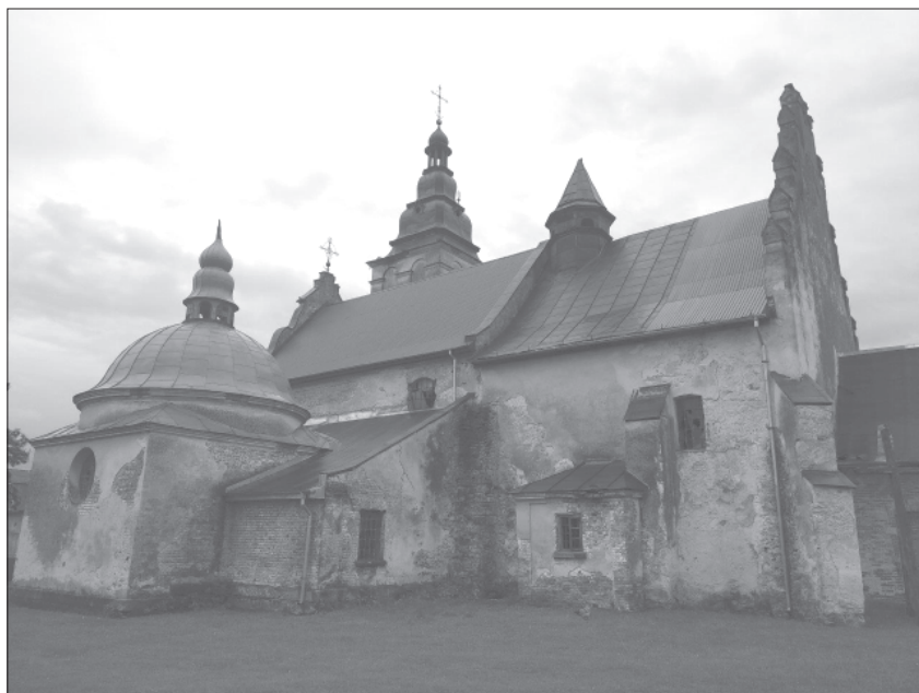
Kościół rzymskokatolicki w Wyźnianiach z naprawionym dachem, 2018 r. Fot. Adam Groblewski.
