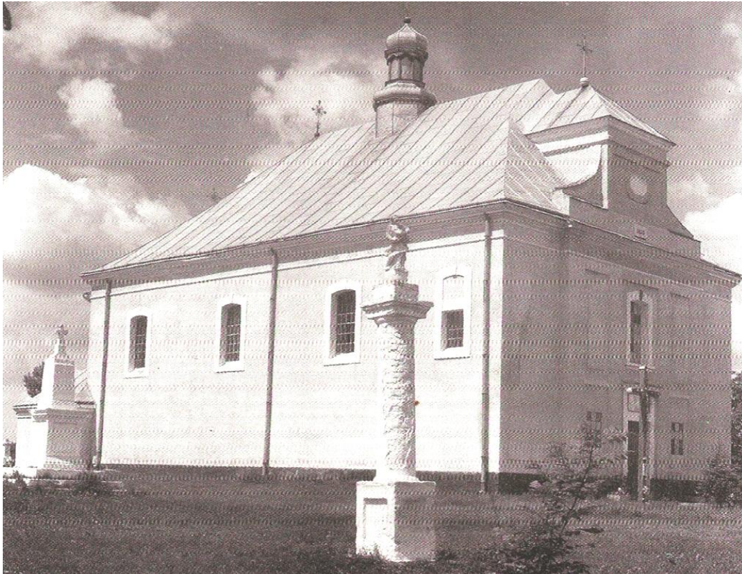
Widok kościoła, obecnie cerkwi, od południowego wschodu, stan z 1997 r.
