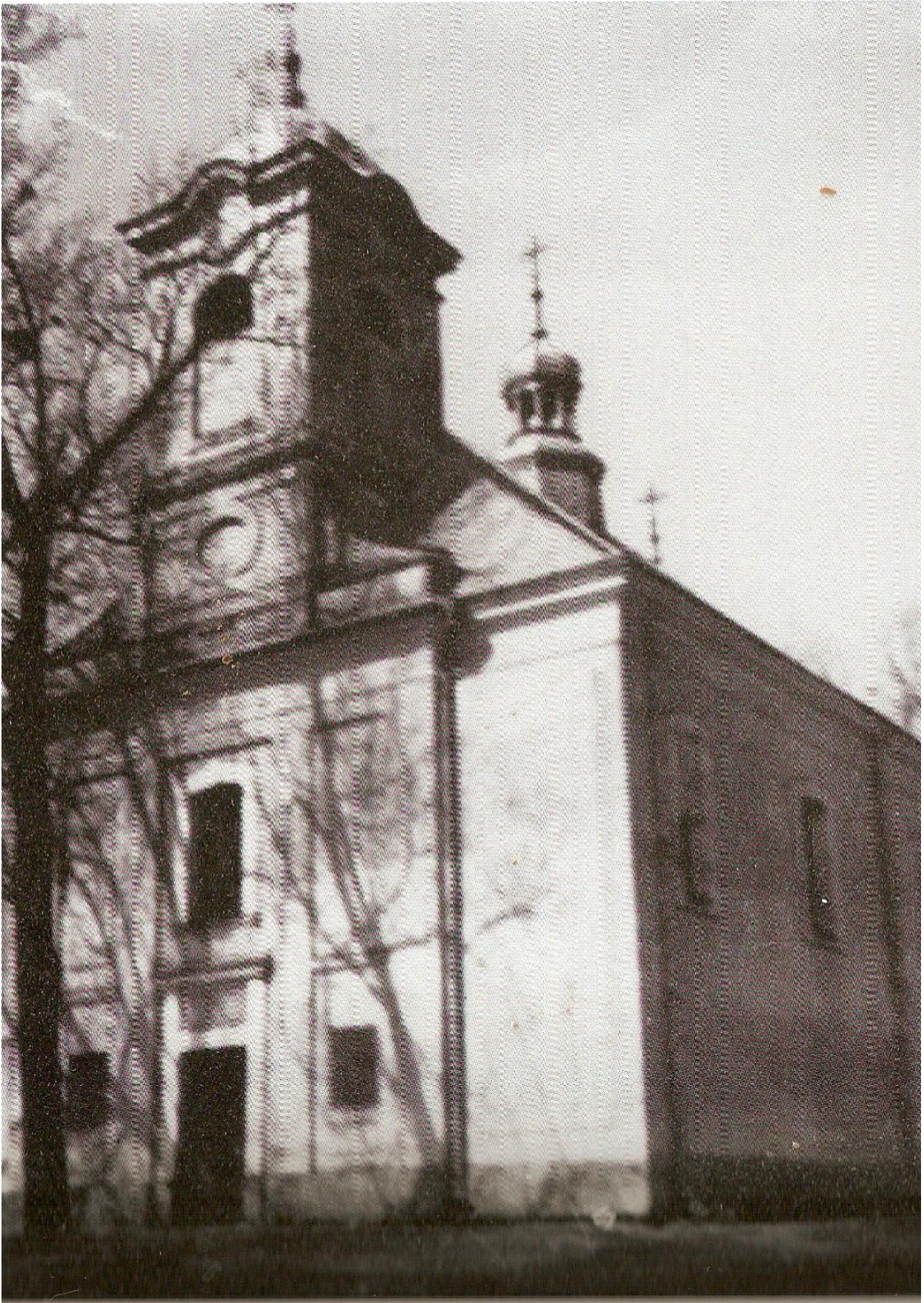
Widok kościoła w Czernielowie od strony północno-wschodniej. Stan sprzed 1939 roku.
